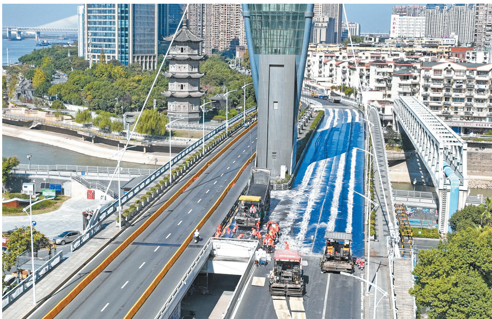
图为正在进行沥青摊铺的临江桥。记者许诚摄
