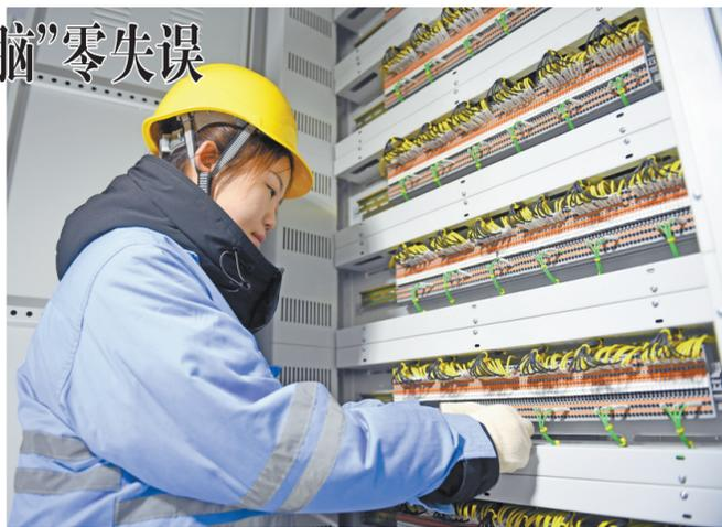
日前,中铁电气化局上海公司芜湖项目部信号作业队正在信号设备室中作业,她们整理线缆,层层码放、核对端口、修改配线……分工明确,配合默契,确保每次施工零失误。
