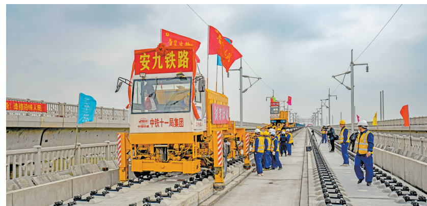
安九高铁湖北段开始铺轨
