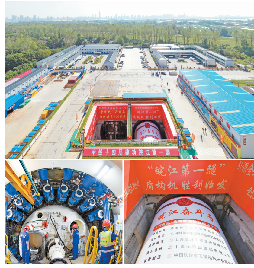
城南过江隧道盾构机“皖江奋斗号”自长江北向长江南始发掘进 记者 郑远 摄
