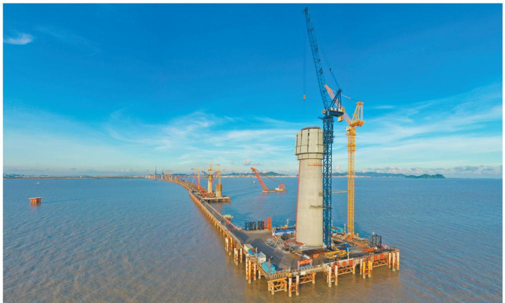
日前，中铁大桥局承建的黄茅海大桥东塔第十二节爬模爬升到位，进入中部塔柱施工阶段。作为黄茅海跨海通道控制性工程，黄茅海大桥主跨跨径达2×720米，桥梁全长2200米。黄茅海跨海通道东起珠海市平沙镇，西接江门市斗山镇，横跨珠江口崖门入海口黄茅海水域，线路全长约31公里。建成通车后，将与港珠澳大桥、深中通道、虎门大桥、南沙大桥等共同组成粤港澳大湾区跨海跨江通道群。
