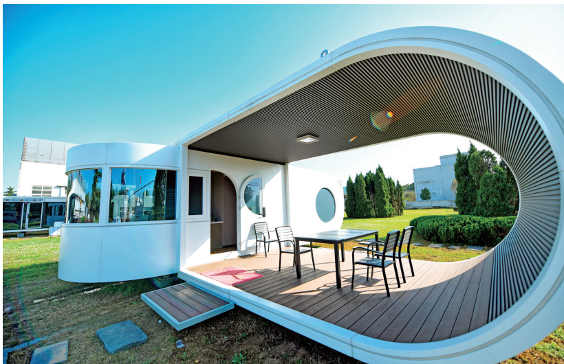
集太阳能热水、光伏发电、储能于一体的可移动“零碳房”。
