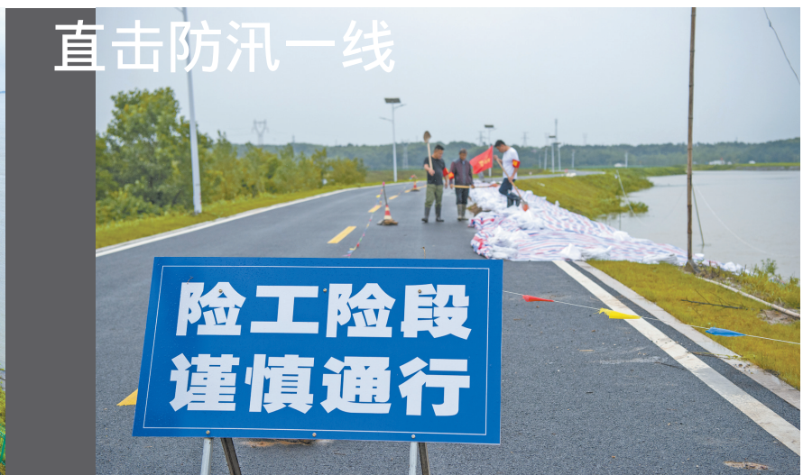
7月2日，在安徽省芜湖市繁昌县孙村镇，巡护人员对长江支流黄浒河堤防的一处险情进行巡查。 新华社发(肖本祥 摄)
